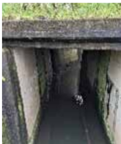
土浦市の冠水、旧湿地帯の排水計画が進んでいる。鶴沼ー神立中央の雨排水路整備工事(出島用水路活用)は①一之瀬川の流下能力がないため鶴沼南の調整池整備3万m 3 、②雨水幹線整備(JR線横断水路拡幅工事(写真)③JR線上流部
