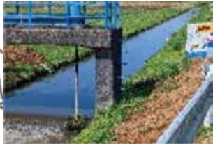
土浦市の冠水、旧湿地帯の排水計画が進んでいる。鶴沼ー神立中央の雨排水路整備工事(出島用水路活用)は①一之瀬川の流下能力がないため鶴沼南の調整池整備3万m 3 、②雨水幹線整備(JR線横断水路拡幅工事(写真)③JR線上流部
