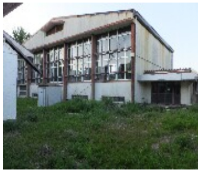
佐賀小学校避難所体育館
